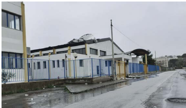
➤ ALESSANO - Seramente danneggiato il tetto della palestra del Salvemini; un albero è caduto proprio nei pressi dell'ingresso dell'Asilo delle Suore: fortunatamente il giorno prima la sindaca Francesco Torsello aveva firmato l'ordinanza di chiusura di tutte le scuole.
