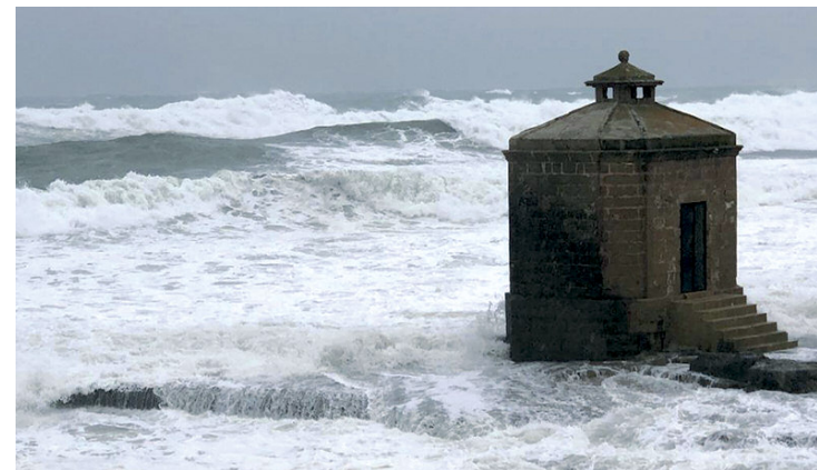
➤ SANTA MARIA DI LEUCA - Danneggiati bar, locali e strutture ricettive sul lungomare, molte barche nel porto soprattutto quelle sequestrate ed ormeggiate al transito. Litoranea temporaneamente chiusa al traffico per un albero caduto di traverso sulla strada.
