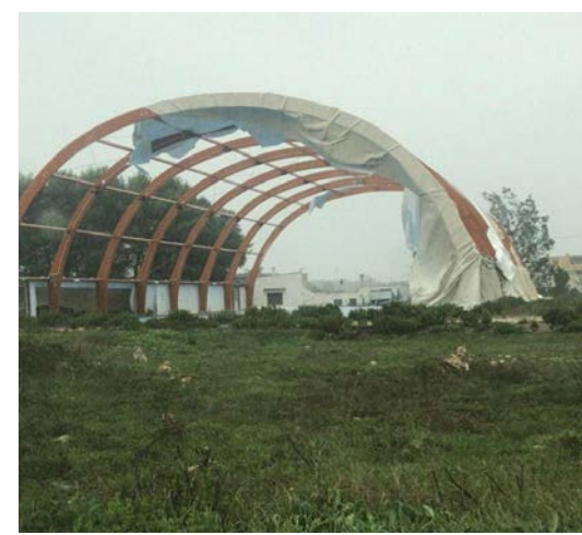
➤ SPONGANO - Palazzetto dello sport in costruzione... completamente da ricostruire! Eolo lo ha spazzato via in pochi secondi.
