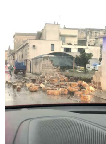
➤ MAGLIE - Muretto in terra in centro, alberi lungo le strade a Maglie, dove sono stati danneggiati anche gli esterni della piscina comunale Fimco.
