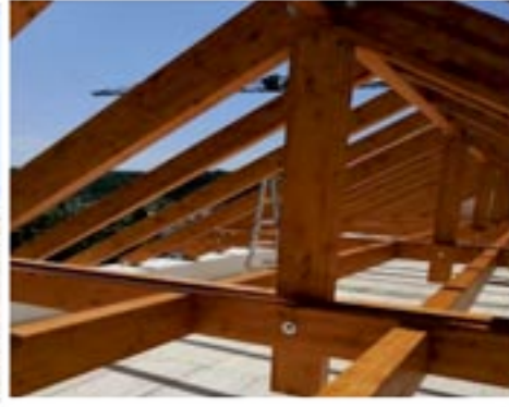
Chiesa di San Michele Arcangelo: solaio navata centrale da gettato in opera a struttura in legno
