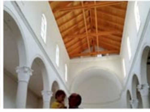
Chiesa di San Michele Arcangelo: solaio navata centrale da gettato in opera a struttura in legno
